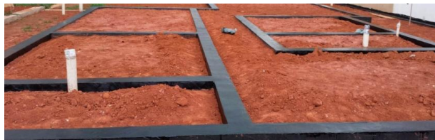
Figura 2: Execução da impermeabilização
