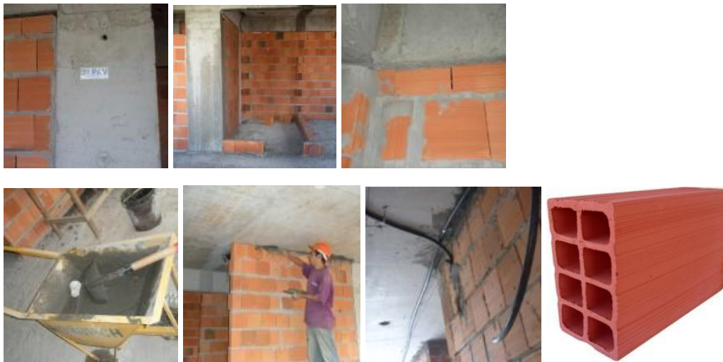
Figura 3: Execução do encunhamento de Blocos e Bloco de Tijolo
