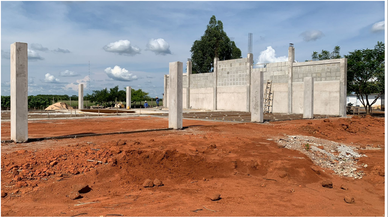
Foto 3: Execução da alvenaria e superestrutura do piso
