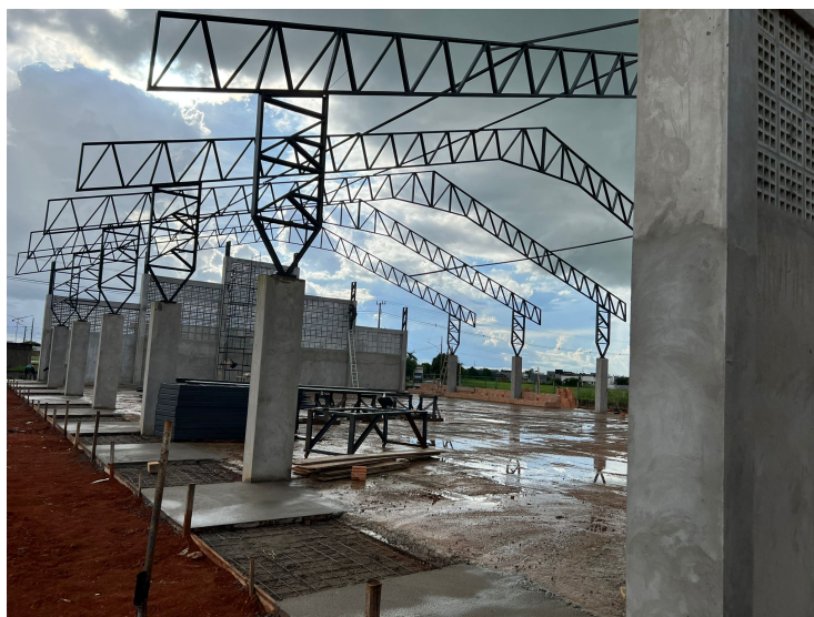
Foto 4: Execução da cobertura
