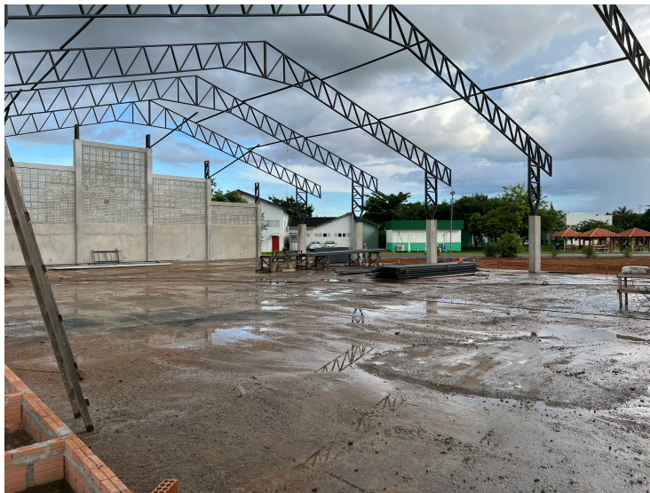
Foto 6: Execução da cobertura e arquibancada
