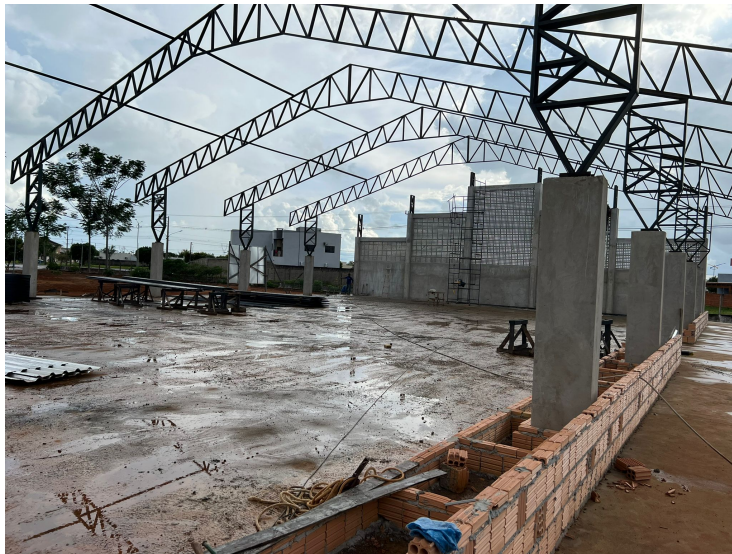
Foto 7: Execução da cobertura e arquibancada
