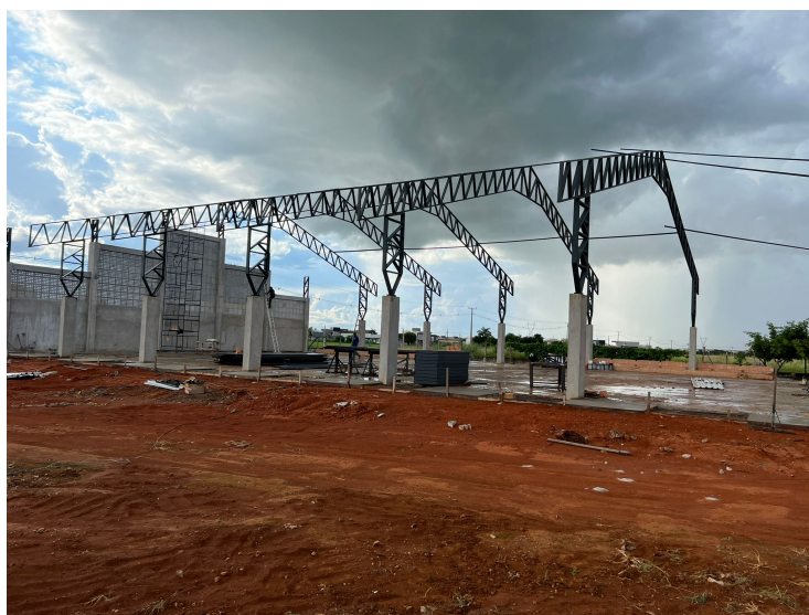
Foto 5: Execução da Cobertura
